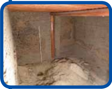
Schäden nach Plünderungen in Abydos
